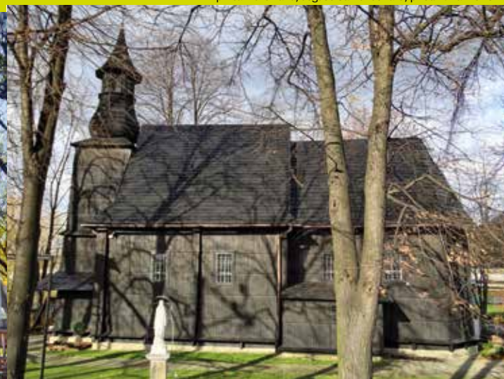
Lipnica Murowana, l'église Saint Léonard, phot. K. Bańkowski
