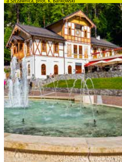
Les constructions thermales en bois à Szczawnica, phot. K. Bańkowski
